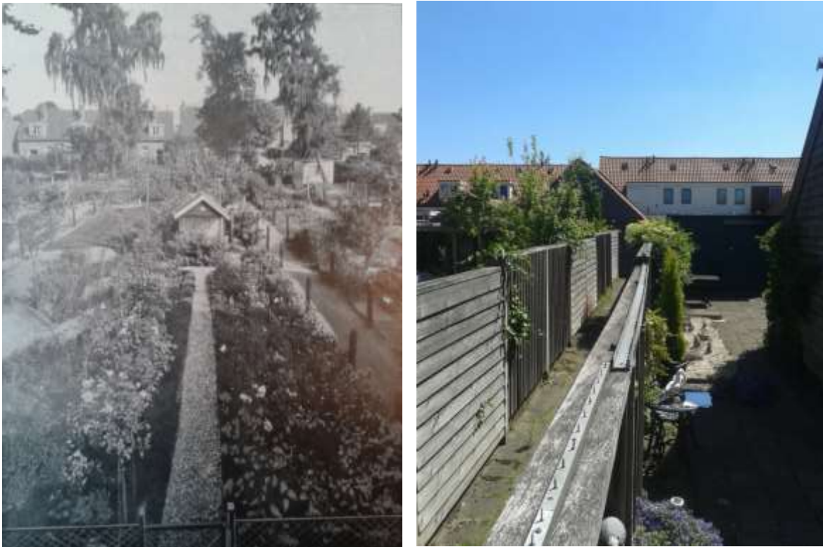
Foto's vanuit de Calicotstraat in de richting van de Janninksweg
